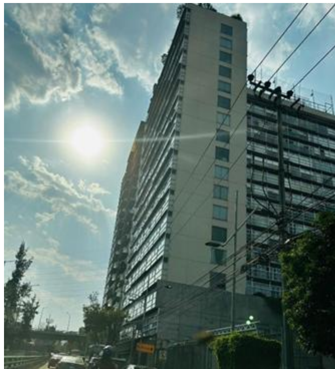
Imagen 14. Inmueble ubicado en Av. Prolongación San Antonio número 413, Colonia San Pedro de los Pinos, Alcaldía Álvaro Obregón. Se aprecia una construcción de dieciocho niveles de altura.
