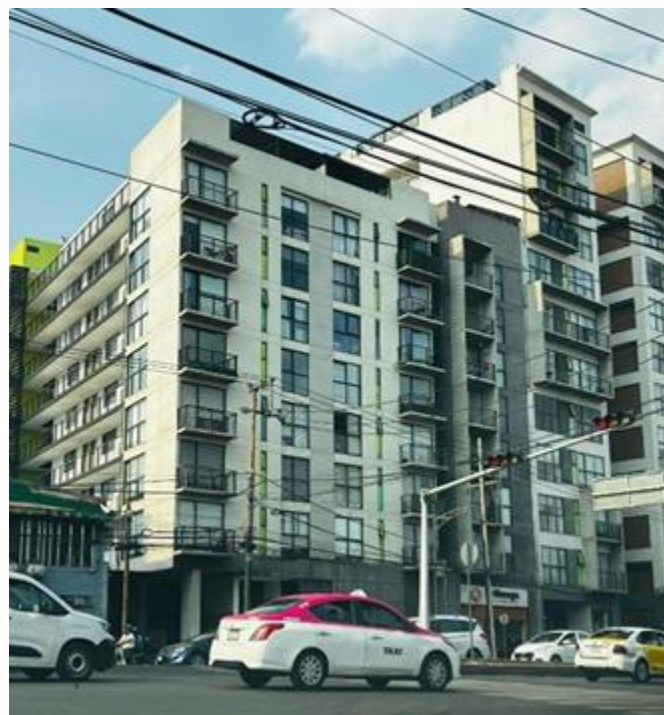
Imagen 12. Inmueble ubicado en Av. Prolongación San Antonio número 135, Colonia San Pedro de los Pinos, Alcaldía Álvaro Obregón. Se aprecia una construcción de once niveles de altura.
