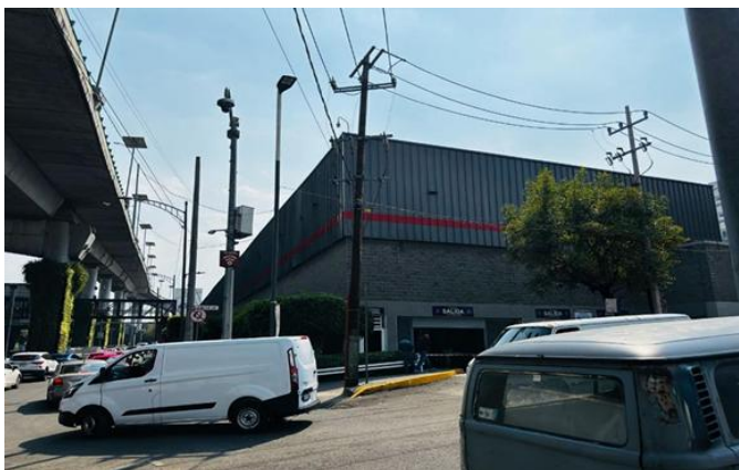
Imagen 5. Imagen tomada al predio de la acera de enfrente, que está ubicado en Blvd. Adolfo López Mateos número 1181, Colonia san Pedro de los Pinos, Alcaldía Álvaro Obregón. Se aprecian dos niveles de altura.
